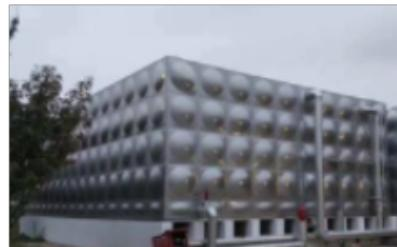
不锈钢水箱是目前世界上使用的一种新型水箱。所用材料为SUS304级食品，目前作为一种清洁储水容器，广泛应用于生活、工业等领域。安装不锈钢水箱要花多少钱？不同原材料，不同容量和不同厂家的不锈钢水箱的价格也会有所不同。因此，当你购买不锈钢水箱时，你必须保持冷静，理性，并做出合理的比较。不锈钢水箱安装方法：1、不锈钢水箱一般可以安装在屋顶上2T以下的水箱不需要单独的基础3T以上的立式水箱是\*\*的基础。水箱就位后，可根据连接孔的大小使用。2、污水排污口为清洗污垢，可与污水连接，可安装螺旋塞吹除污水，用户可根据情况进行处理。3、溢流口用于水箱溢流和浮阀溢流。它可以连接到污水，可以在现场排水。4、立式（平底）水箱，底部带孔法兰，可以用铁丝和墙壁紧固，也可以单独用膨胀螺丝固定。5、浮球阀须定期检查(一般为1至3个月)，如发现有故障，则须及时修理。因此不锈钢水箱需要知道具体情况，比较好就是咨询专业的水箱公司如水箱。
