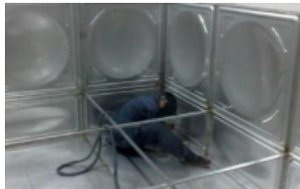
不锈钢水箱现场制作过程以及要求1、在进场前，要按照合同要求来清点水箱模块及底板数量、厚度、配套材料等。2、进场后，先焊接模块的四个折边角，焊缝位置为四角内边，焊接高度为角部这边的3/5高，焊角过渡要均匀平滑，不得漏水。3、焊接水箱底板，焊缝要均匀整齐，不得有气泡、焊坑等缺陷。4、在组装前，按照图纸要求选定相应板厚的模块，将模块四周折边敲正校平，先将下侧板点焊于底板四周，点好后，测量四周方框的两条对角线长度，误差不得大于2mm。要保证已点焊后的下侧模块整体横平竖直组合方正。5、焊接下侧模块与水箱底板的四周，焊缝要均匀平滑，不得漏水。6、按照第四个工序要求来组装、点焊水箱上侧板模块，点焊校正后焊接中上侧模块的纵横拉筋，以稳定中上侧墙板，保证水箱方正不变形。7、满焊水箱模块的全部内折边焊缝；焊接水箱顶板模块，焊接前，要确定好人孔的焊接位置，顶板焊接好后，焊水箱内拉筋立柱。8、检查水箱焊缝是否有缺点或漏焊，如果有要加补好，然后再试水、检查、补漏。福建大型不锈钢水箱特价不同材质的不锈钢水箱的差异和区别？
